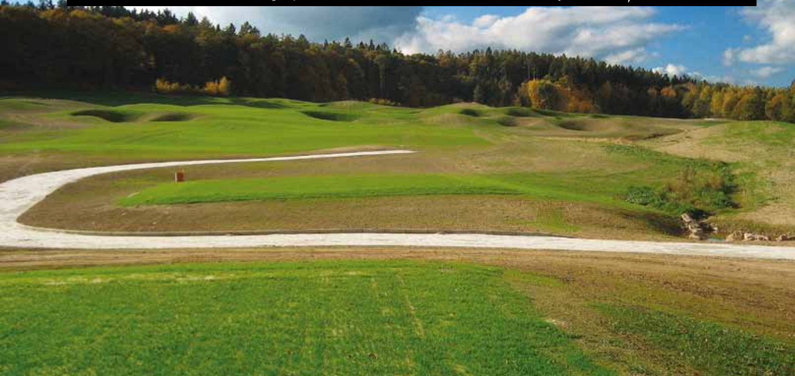
Na golfovém hřišti Casa Serena byl vybrán povrch skládaný ze zámkové dlažby. Na snímku vidíte umístění cestičky u odpališť jamky č. 5. Je velmi důležité, aby výstavba chodníků byla dokončena před zahájením setí...
