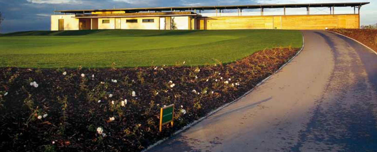
Albatross Golf Club, Vysoký Újezd. Vzor dobře provedeného asfaltového chodníku v optimální šířce pro frekventovaný pohyb hráčů mezi klubovnou a driving range. Vlevo je chipping area
