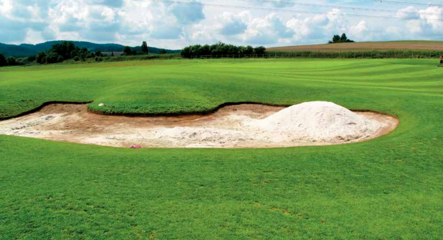
Detail approach bunkeru Golfvé Akademie Čapí hnízdo těsně před dokončením
