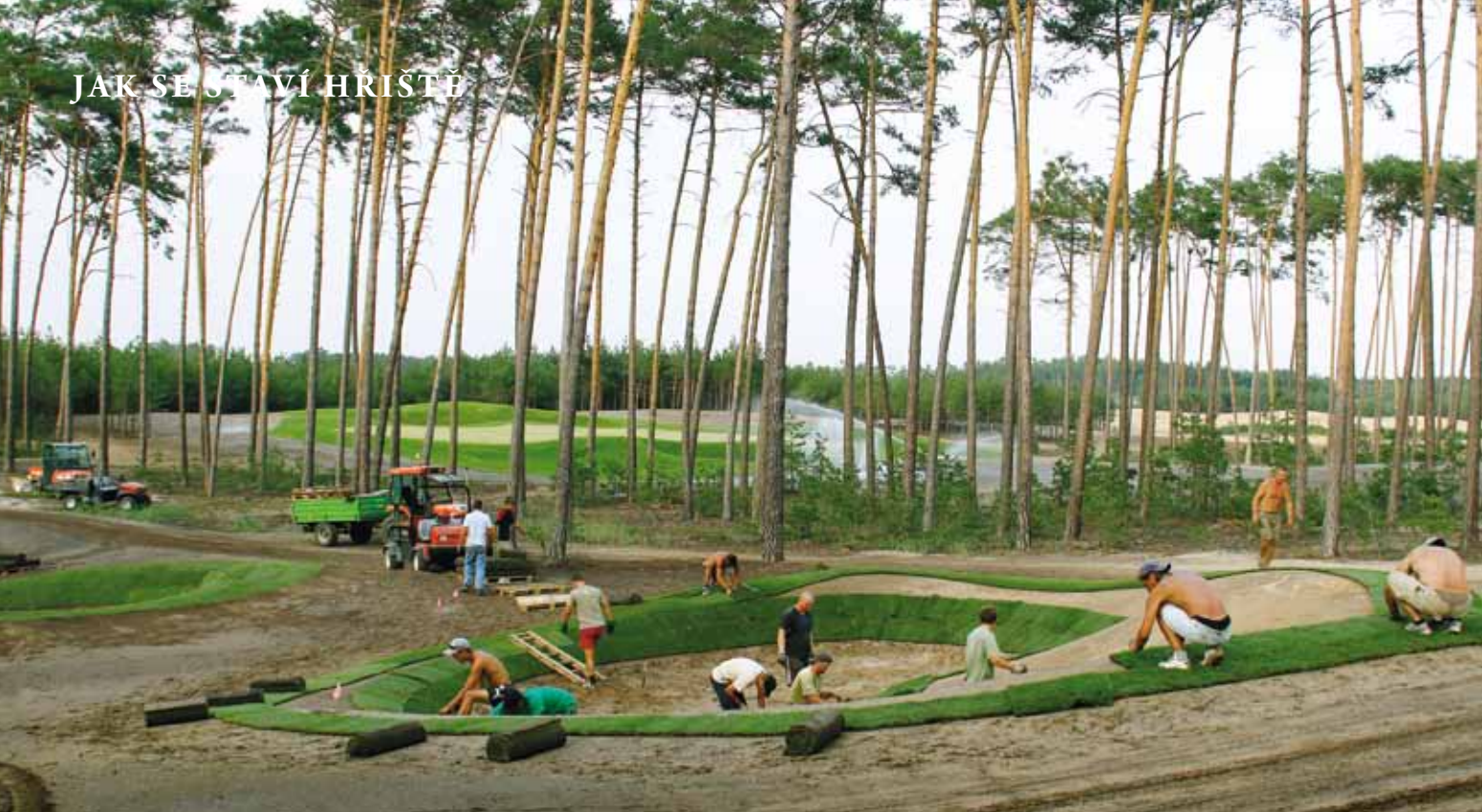
Jamka č. 4 a instalace travního drnu na stěnu fervejového bunkeru. V pískovém prostředí je instalace travního drnu jedinou možnou cestou, jak zachovat ostré tvary modelace a zároveň zabránit erozím.
